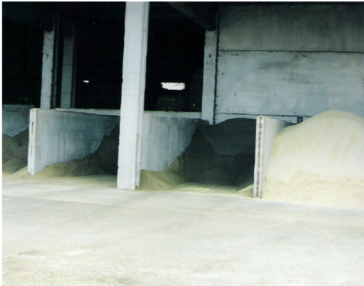
Foto 2 : sistemazione di alimenti in strutture prefabbricate
